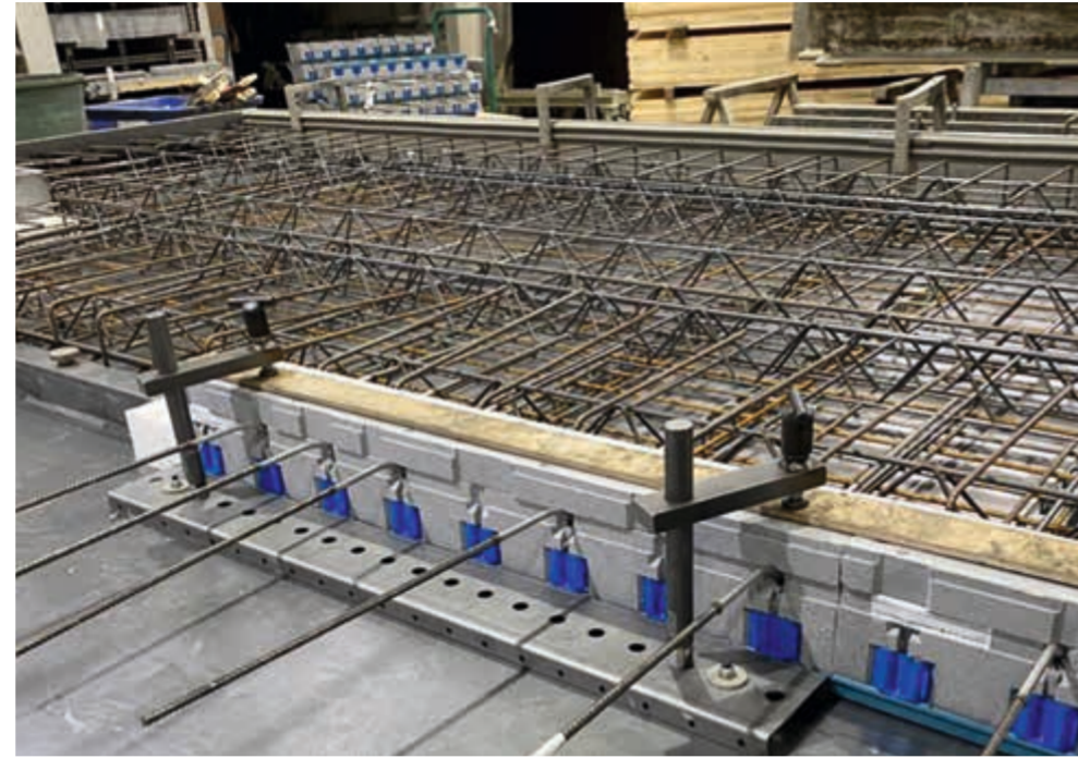
Solución adaptadora para elementos de aislamiento térmico para conexiones de balcones
