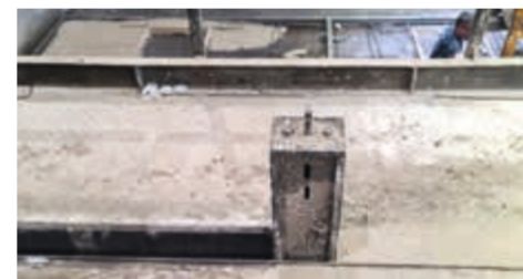
Encofrado lateral interior para moldes de batería
