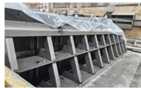
Encofrado de soporte para espesores de muro de hasta 120 cm
