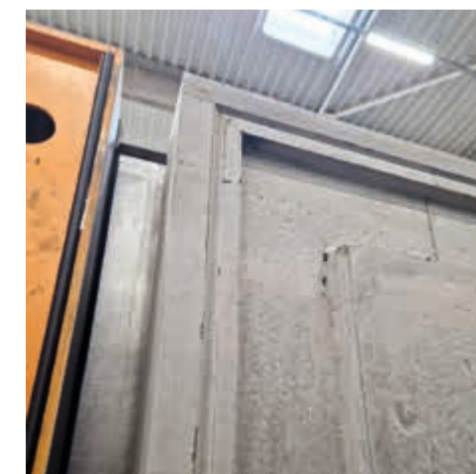
Elemento de techo terminado
