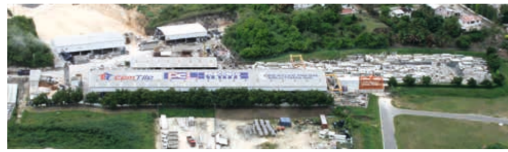
Vista aérea de la planta de Preconco Ltd.
