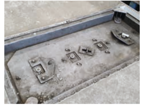
Hueco de puerta retráctil
