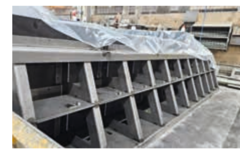
Stützschalung für Wandstärken bis zu 120 cm
