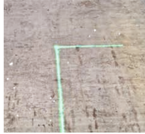
Neue Laser erleichtern das Einschalen der Elemente
