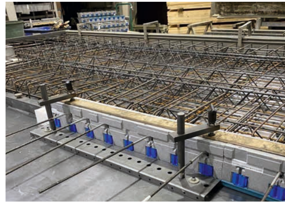
Adapterlösung für Wärmedämmelemente bei Balkonanschlüssen
