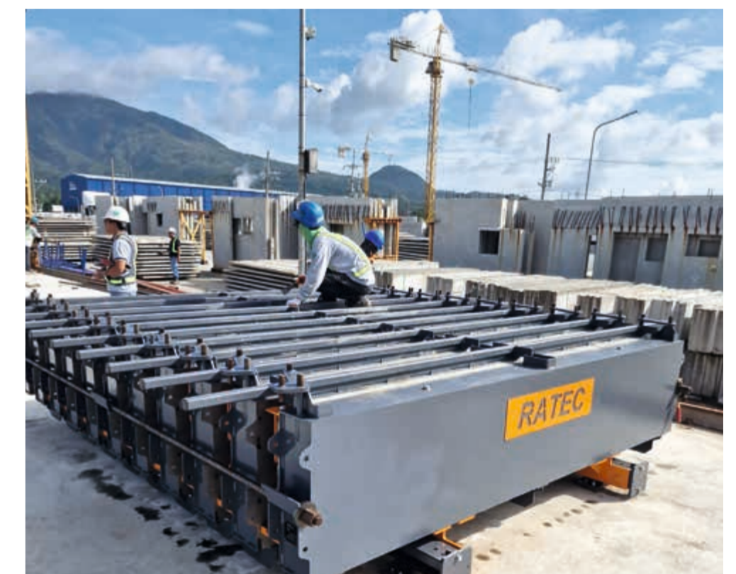
Batterieschalung mit zehn Taschen für ca. 2,7 Meter lange und 60 Zentimeter hohe Wände
