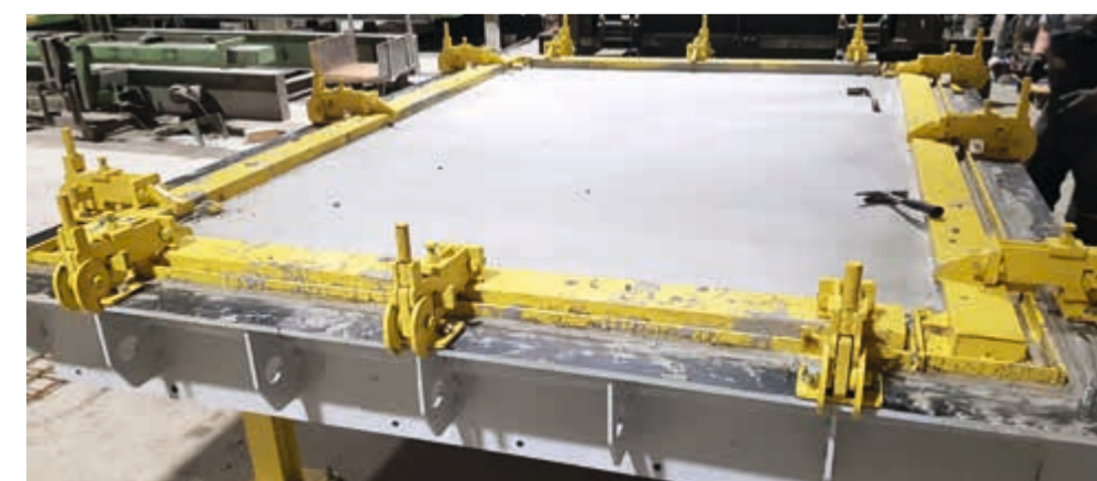
Dachschalung für die horizontale Fertigung
