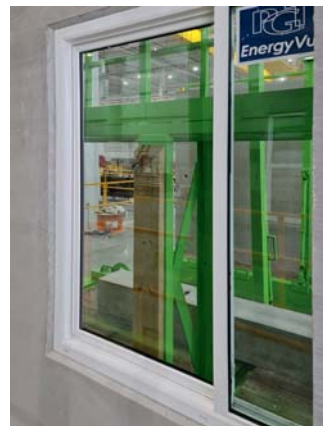
Komplett einbetonierte Fenster – eine Besonderheit der Anlage
