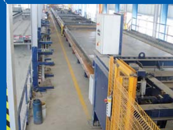
Barbados, Preconco / Carribean Homes Anlagenplanung, Massivwandanlage
