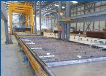
Panama, SCI Anlagenplanung
