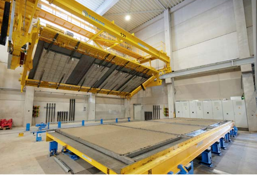
Wendestation beim Einwenden der 1. Schale für die Doppelwand
