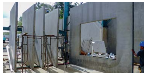
Indonesia: Producción de elementos de fachada de 3,9x9 m
