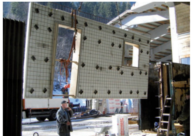
Vorgefertigter Bewehrungskorb
