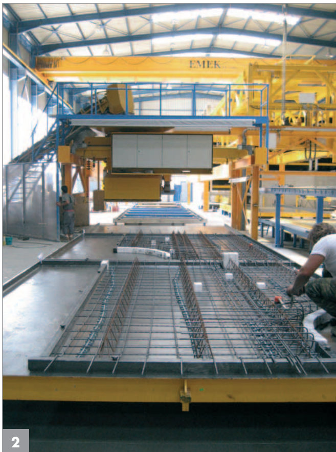
Die Elementdecken werden bereits während der Produktion mit Einbauteilen versehen
