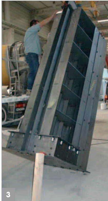
3 Gekippte Schalung, füllen von oben
