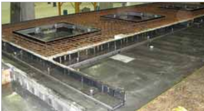
SAS-MF mit Holz- und Stahl-Anbaumodul bei Längs- und Querabschalungen
