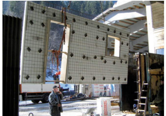
Gabbia di armatura prefabbricata
