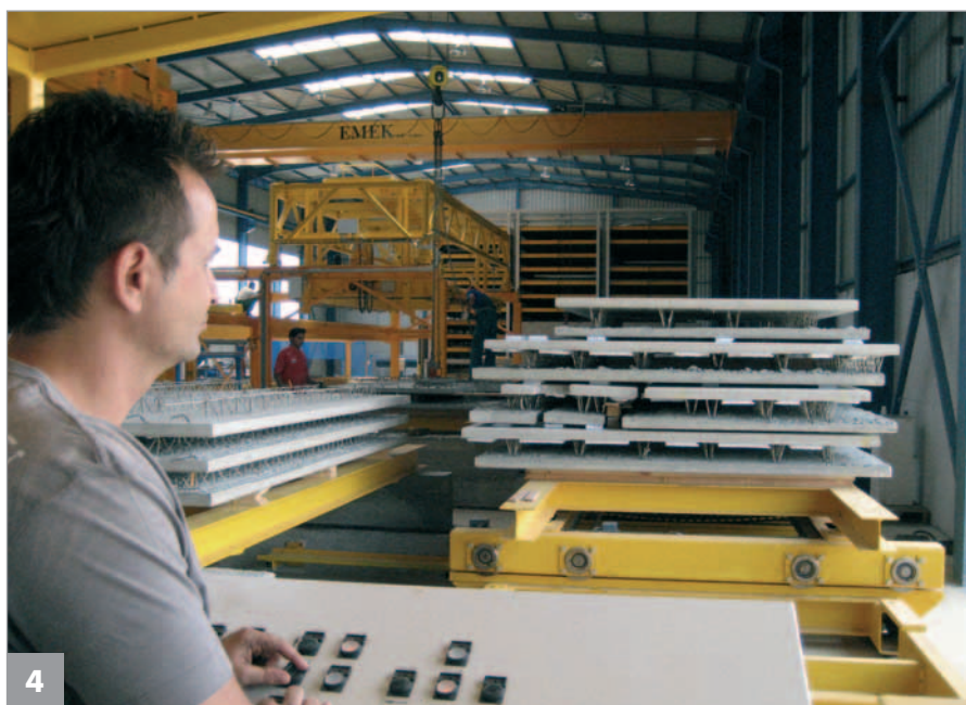
I solai in elementi prefabbricati e le pareti doppie vengono preparati, pronti per l'installazione, per il trasporto
