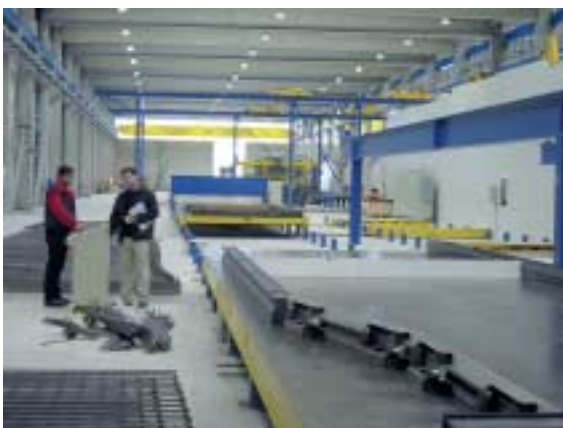
Puesta en marcha en colaboración e instrucción de HLE por parte de Reymann-Technik Partnership in commissioning and training for HLE from Reymann-Technik
