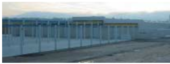
Vista del complejo de producción View of the production complex
