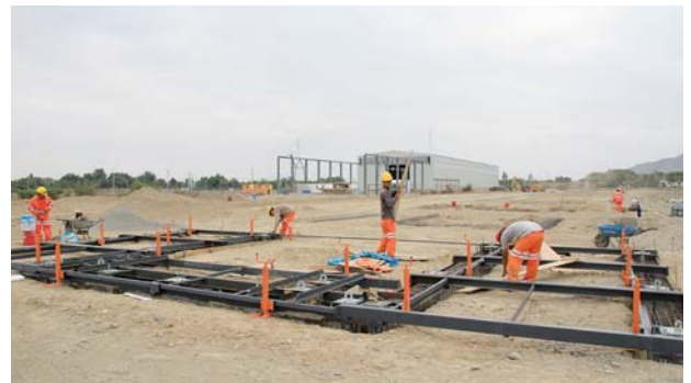
Auch die Fundamente werden an Ort und Stelle vorgefertigt.
