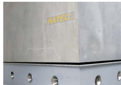
Scharfe Kanten und allseits schalungsglatte Flächen
