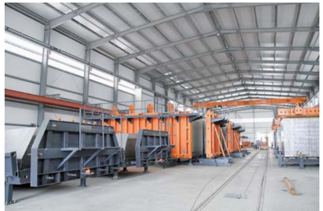
Modul- und Dachschalungen im neugebauten Werk in Ica
