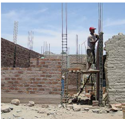
Beispiele konventioneller Bauweise in Peru
