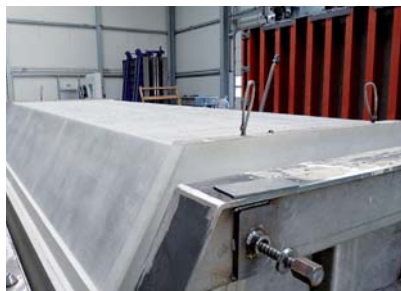
Probet betonieren des Dachelements
