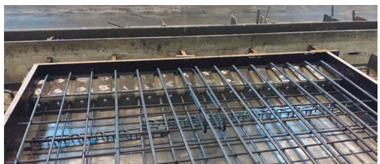
Schalung mit Deckenaufleger-Kiste
