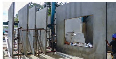
Indonesien – Produktion von 3,9x9m Fassadenelementen
